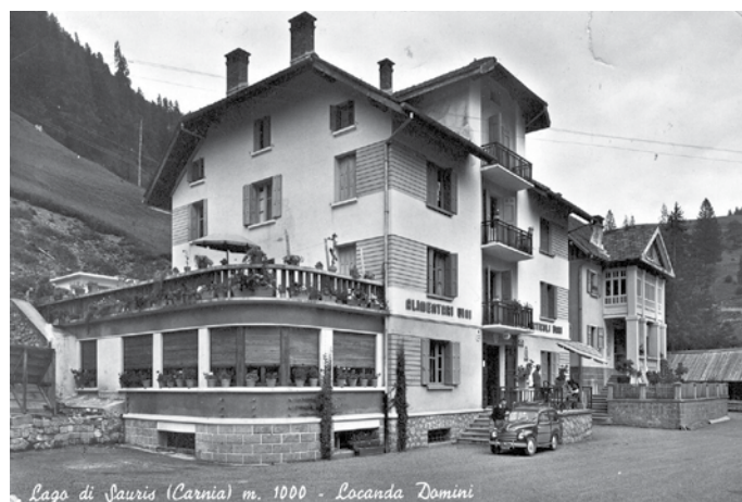
Maina. Locanda Domini (Sauris) in una cartolina d'epoca. Di qui passa la strada Höle, nome ora caduto in disuso.
